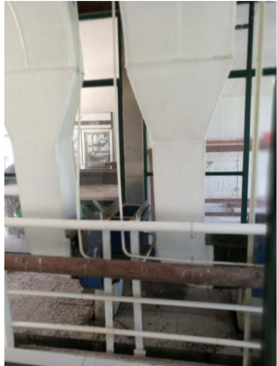
油烟净化设备排风口
