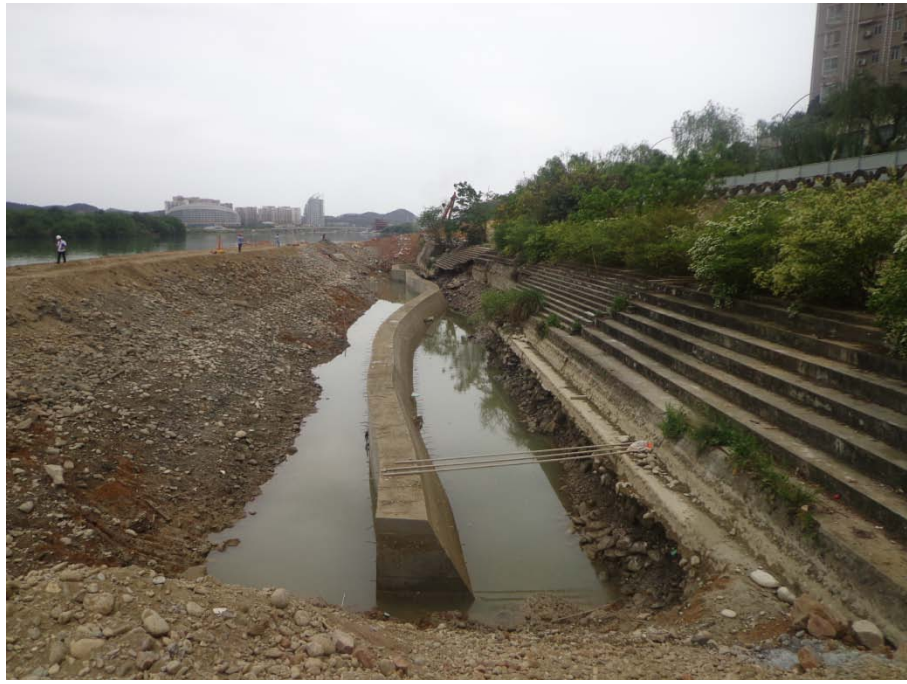
图 7-4 施工期码头前沿土石围堰及挡墙
