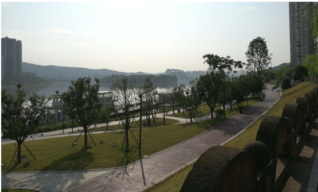
淤泥抛泥区恢复现状
