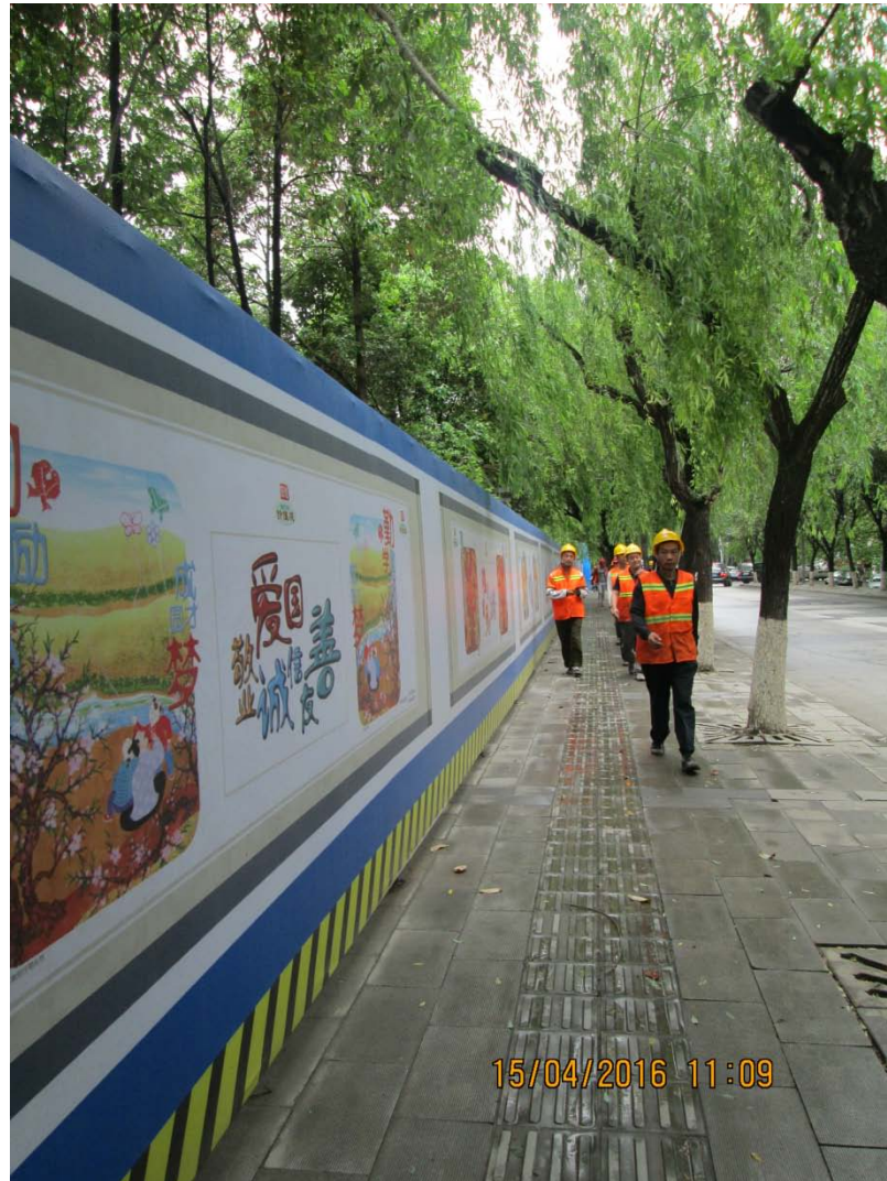
图 7-3 施工期临时围挡
