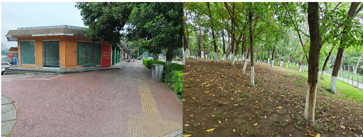
松林坡拟拆除建筑
